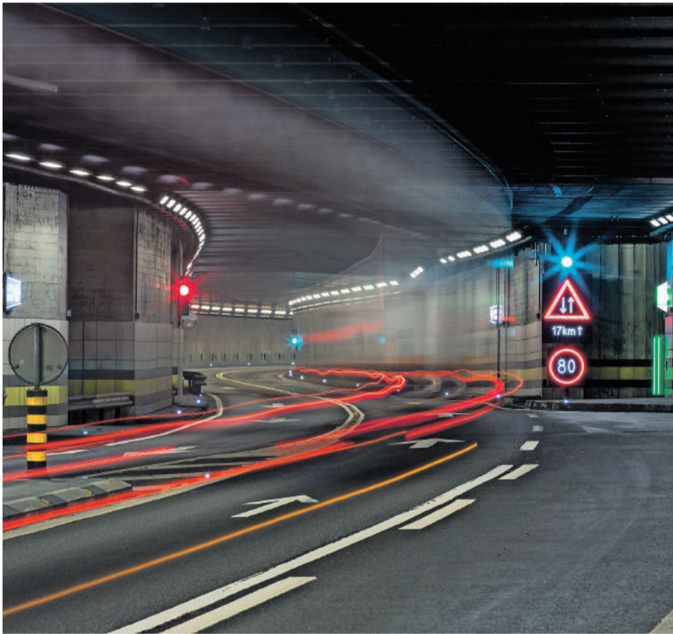
Die Tunneldecke im Gotthard-Strassentunnel wird von 4,50 auf 4,80 Meter angehoben. Foto: Gaëtan Bally (Keystone)
